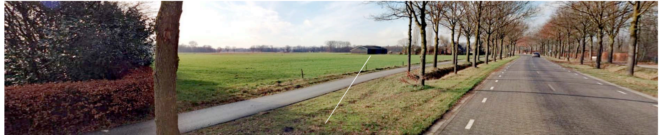
1) zicht op de zuidoostkant over afstand, de berging toont zich kaal aan de passant
