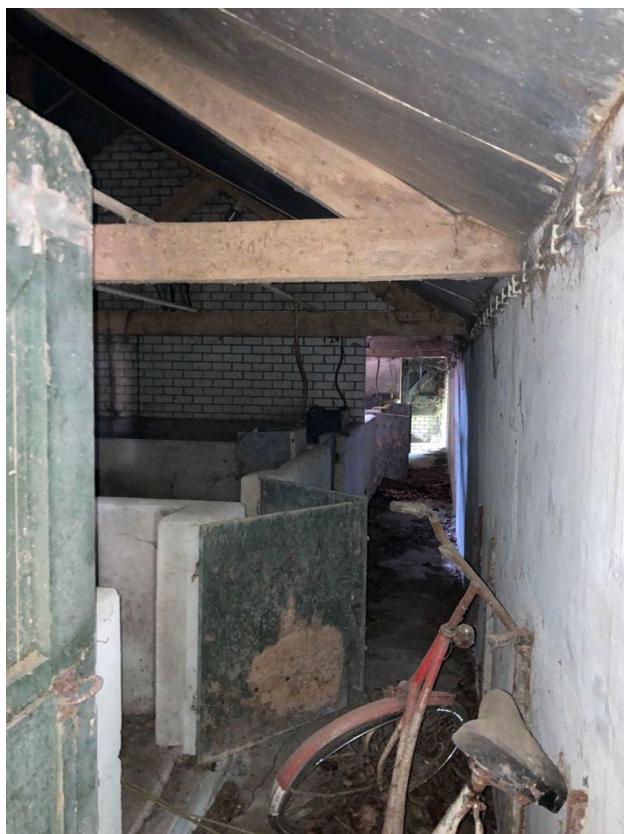
• Afbeelding 19: binnenkant te slopen varkensstal
