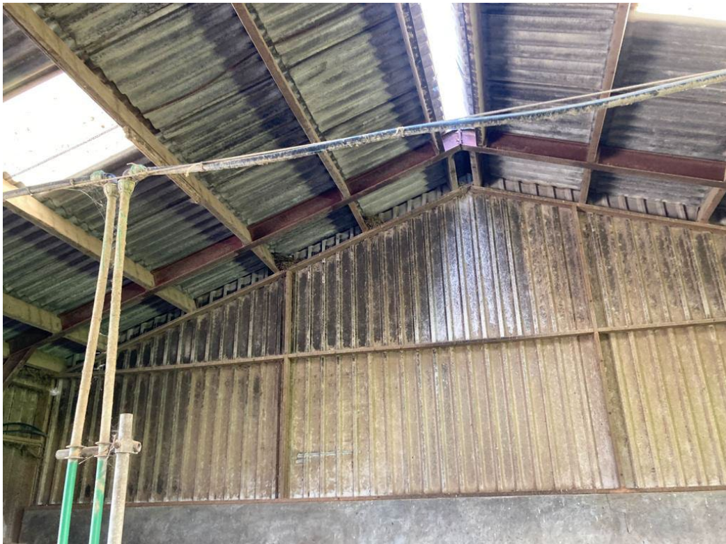
• Afbeelding 14: gedeelte schuur achter die behouden blijft
