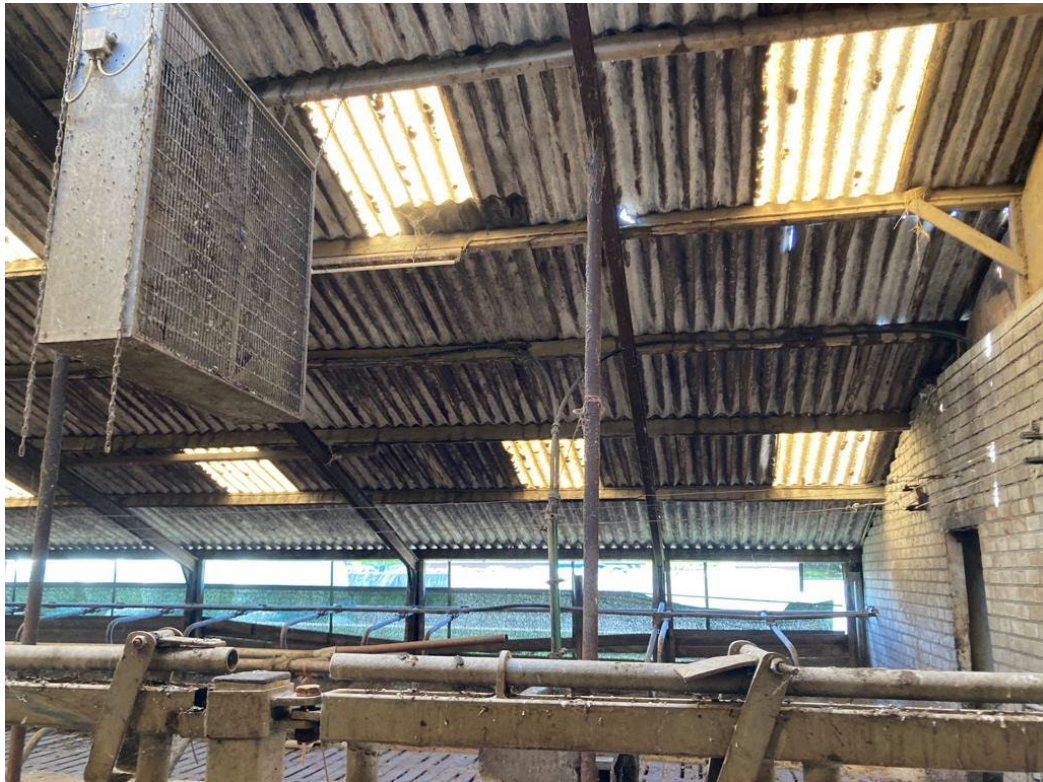
• Afbeelding 9: te slopen ongeïsoleerde rundvee stal
