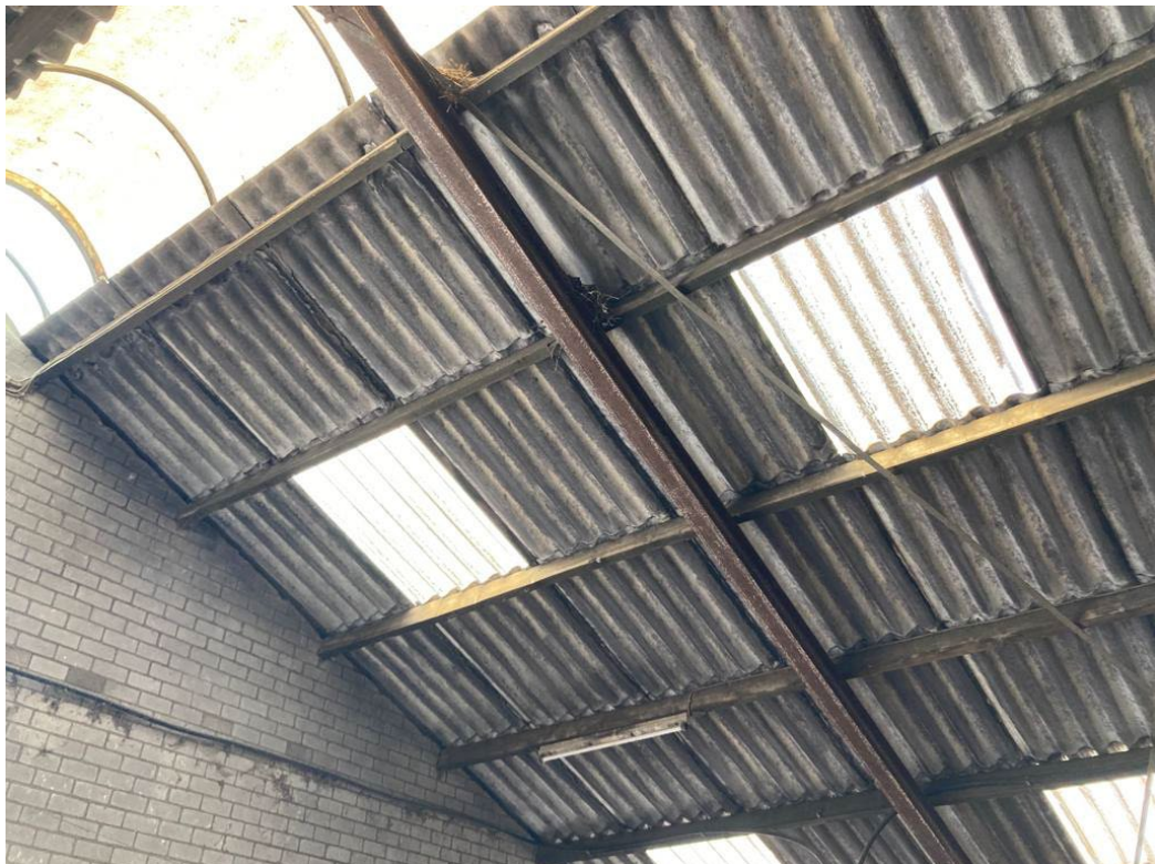
• Afbeelding 10: detail van dak
