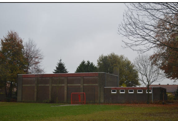
De huidige gymzaal zal gesloopt worden en hier dienen enkele woningen voor in de plaats te komen. Het bestaande sportveld aan de voorzijde wordt gehandhaafd. Aan de achterzijde van de zaal staan eveneens meerdere hoge bomen die voor windbelemmering zorgen bij wind uit noordwestelijke richting.
