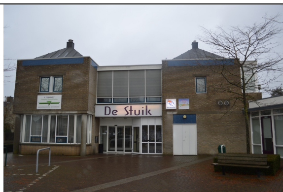
De hoofdentree van De Stuik vanaf de Schoolstraat gezien. In dit pand zijn diverse voorzieningen ondergebracht. Aan de achterzijde langs de Eggerlaan moet een nieuwe uitbreiding verrijzen die onderdak moet geven aan een gymzaal. Hiervoor dient een bestaande woning gesloopt te worden.
