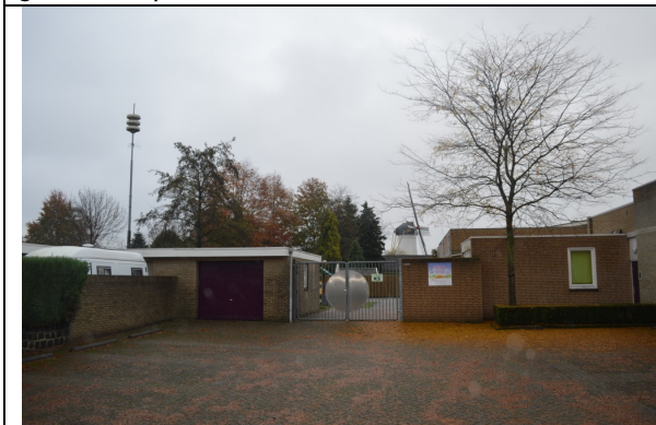
De plek waar de uitbouw van De Stuik dient te worden gerealiseerd. In het midden de molen. Geheel links de erfgrans van het perceel waar de te slopen op is gesitueerd.
