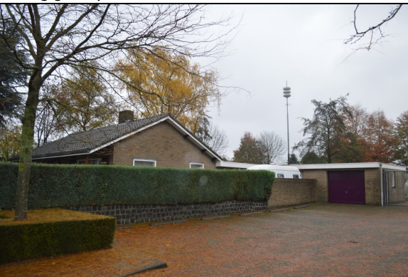
De te slopen bungalow langs de Eggerlaan. Hier dient een gymzaal met een hoogte van 9 meter te verrijzen. Deze locatie ligt op een afstand van ongeveer 100 meter ten westnoordwesten van de molen.
