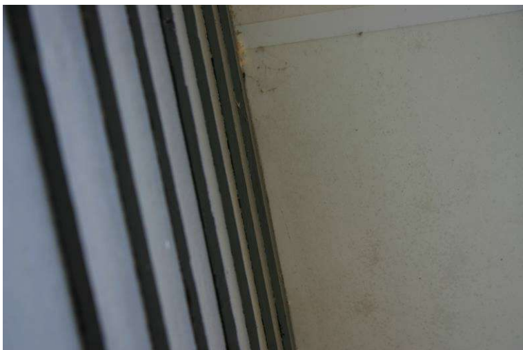
Figuur 4.2.1. De houten gevelbekleding van het bedrijfspand kiert nergens, waardoor vleermuizen geen toegang tot het gebouw hebben.
