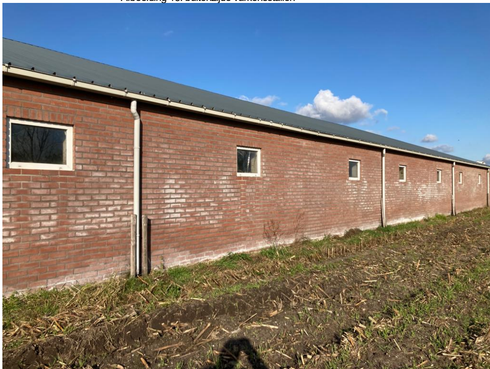
• Afbeelding 18: buitenzijde varkensstallen
