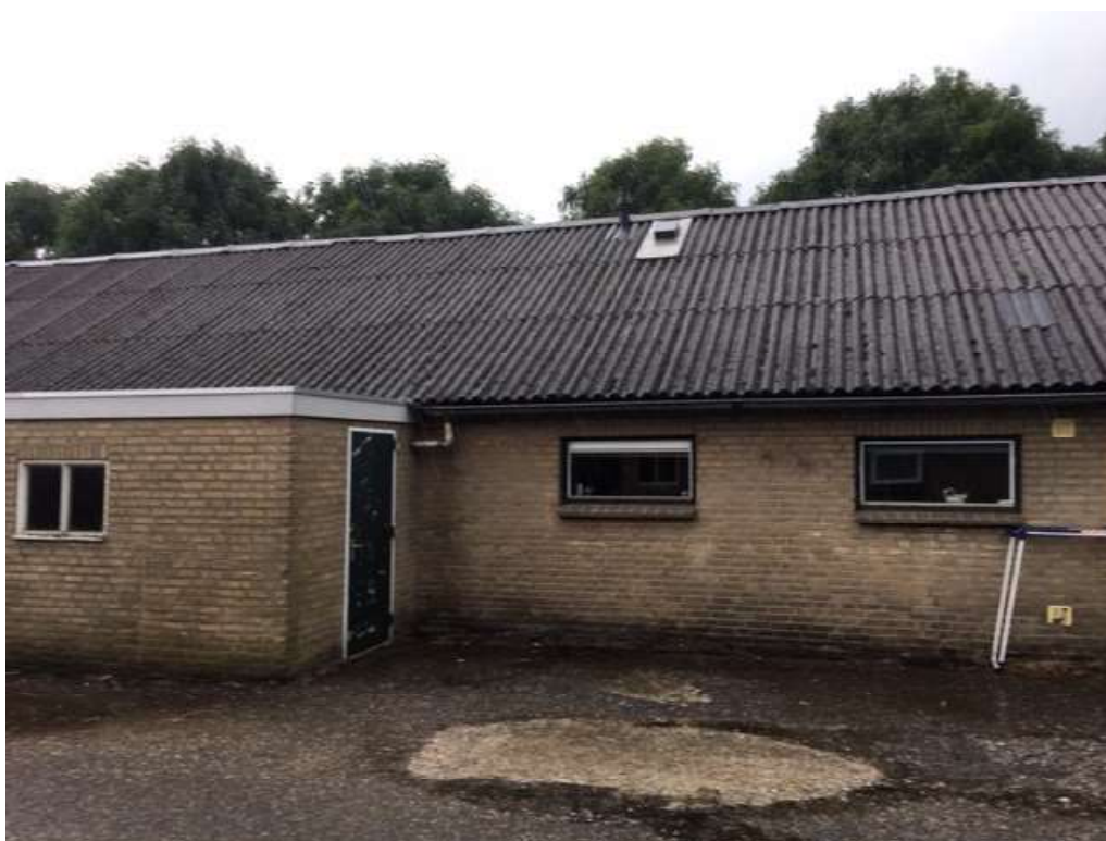
• Afbeelding 22: Zijkant te slopen woning
