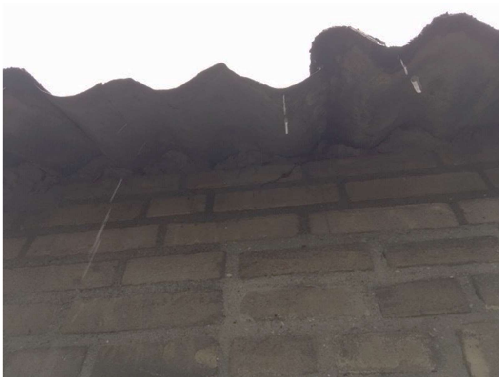
• Afbeelding 19: Detail dakaansluiting op de gevel, met specie dichtgezet
