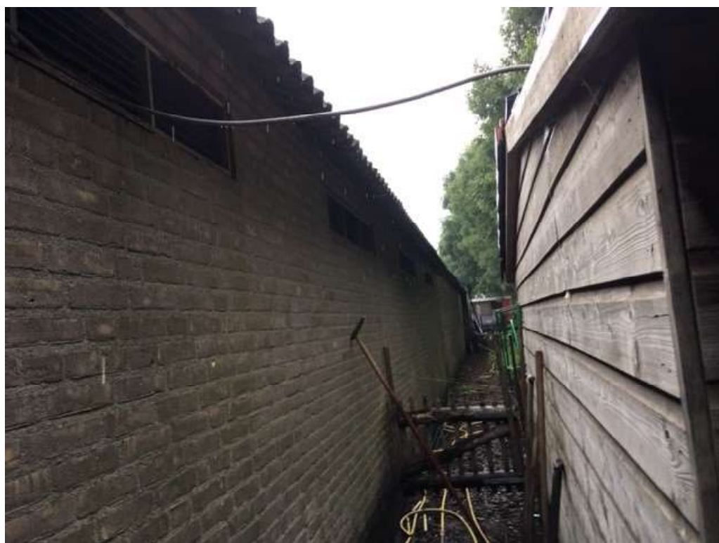
• Afbeelding 18: Zijgevel te slopen woning
