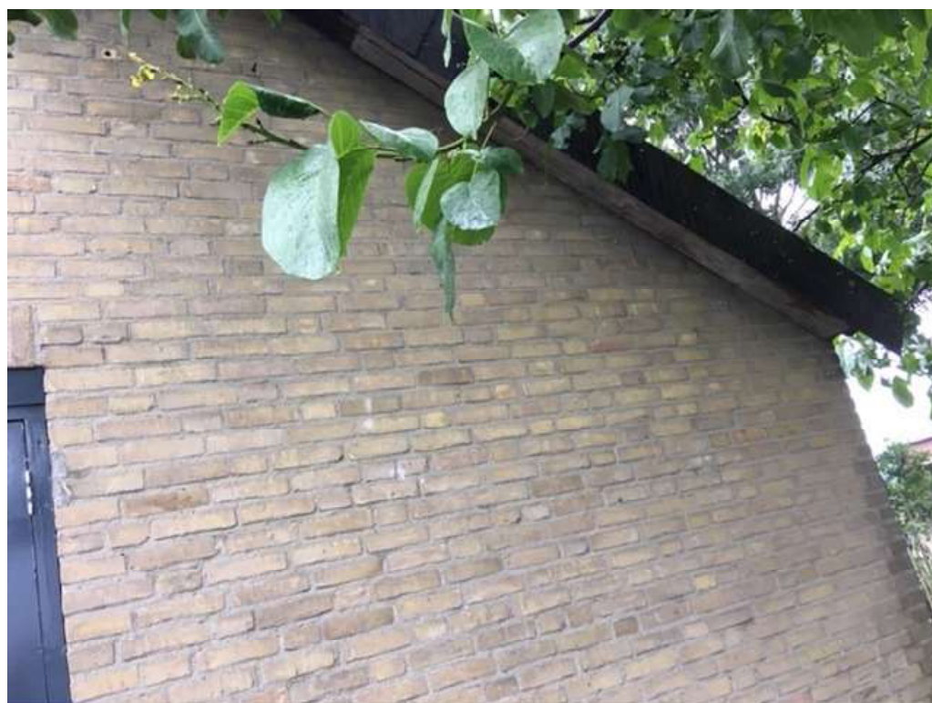
• Afbeelding 20: Detail voorzijde te slopen woning
