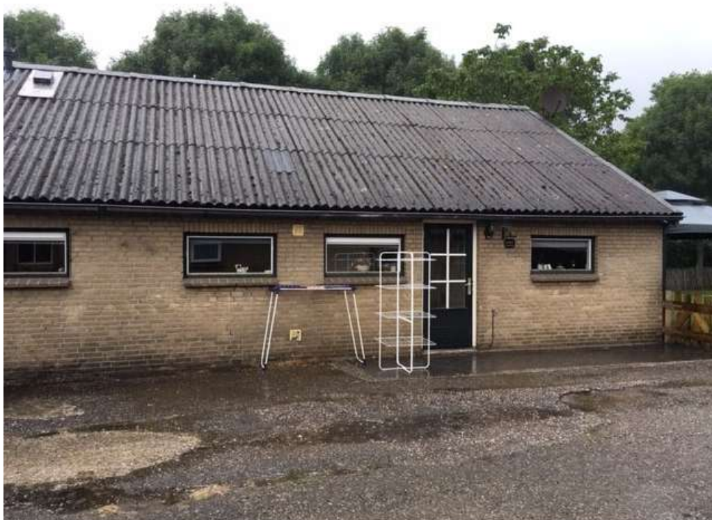
• Afbeelding 23: Zijkant te slopen woning
