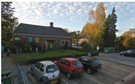
Bestaande bebouwing voormalige school vanaf de Abdijsstraat
