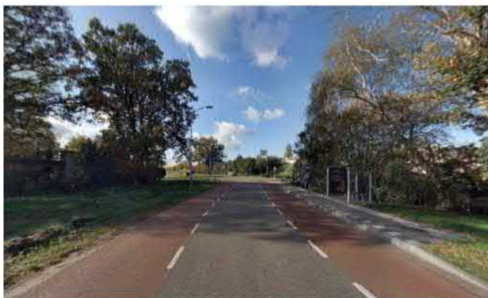
Figuur: 4.4: Huidige situatie Bosschebaan (bron: Cyclomedia).
