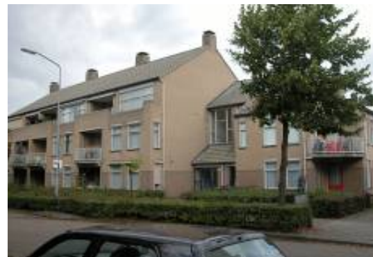
Woningbouw op de hoek Hoogstraat/Pastoor Scheepensstraat
