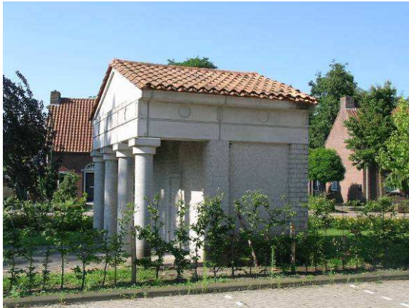
Afbeelding 5.6. Aanwezig gebouw binnen het plangebied Gymnasium.
