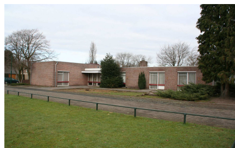
Bestaande bebouwing vanaf Toniesplein
