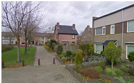
Bebouwing oostzijde Toniesplein
