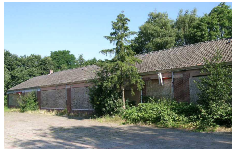
Bebouwing op het binnengebied
