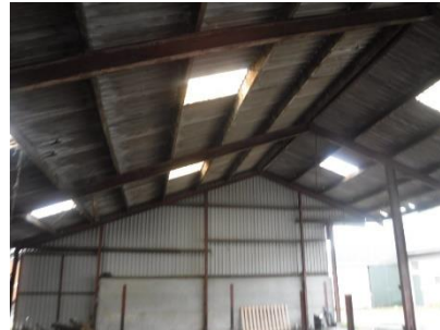
Foto 2 binnenkant dak schuur
