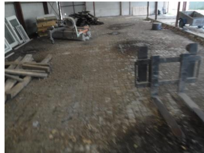
Foto 6 straatwerk in schuur
