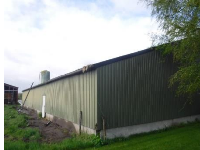
Foto 8 metalen gevelplaten schuur
