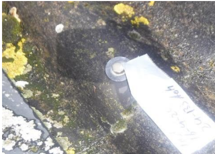
Foto 1 M01 asbestvrij dak schuur
