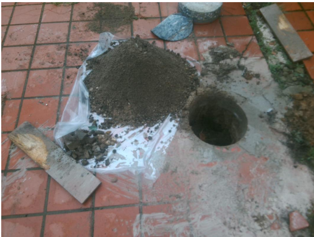
Foto 14: asbestinspectiegat 14
