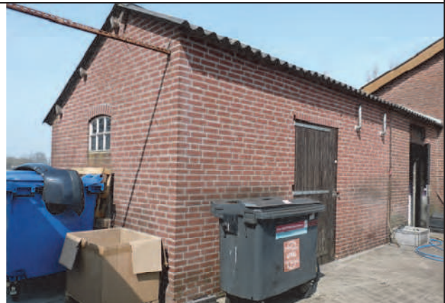
Fig. 8. Te slopen schuurtje, gezien vanaf de zuidkant
