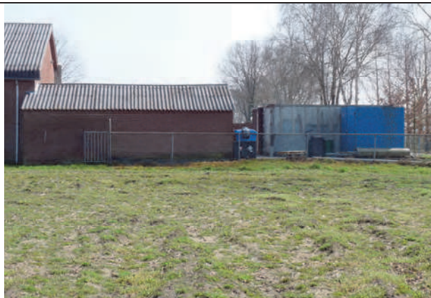
Fig. 7. Te slopen schuurtje, gezien vanaf de noordkant
