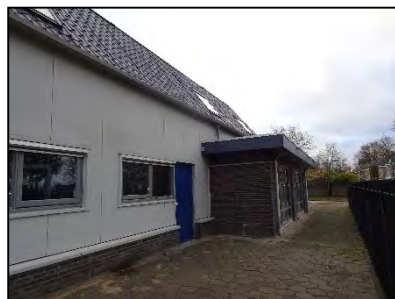
Figuur 2-5. Bedrijfsgebouw, kijkrichting noord.
