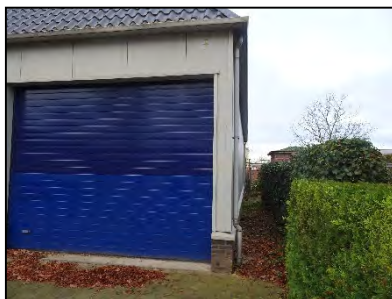
Figuur 2-6. Bedrijfsgebouw, kijkrichting zuidwest.
