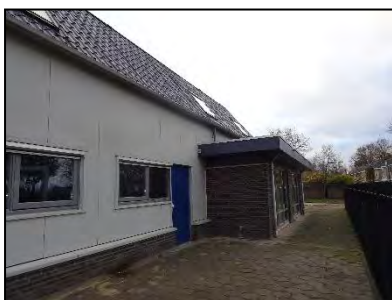
Figuur 6. Bedrijfsgebouw, kijkrichting noord.
