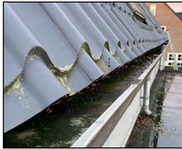
Figuur 11. Dakgoot van het bedrijfsgebouw.
