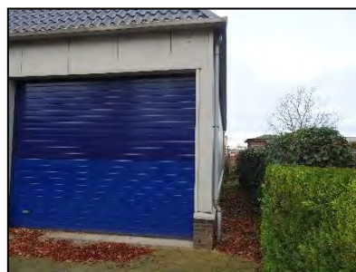
Figuur 7. Bedrijfsgebouw, kijkrichting zuidwest.
