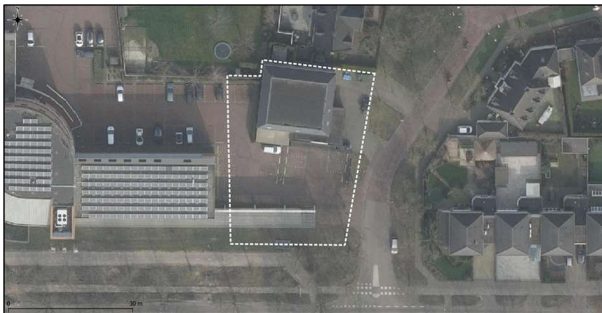
Figuur 2-1. Luchtfoto van de onderzoekslocatie.
