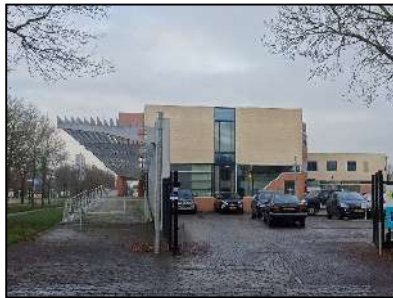
Figuur 2-2. Zuidelijk deel van de onderzoekslocatie (hellingsbaan en parkeerplaats).
