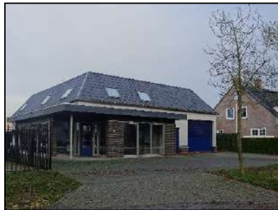
Figuur 2-3. Noordelijk deel van de onderzoekslocatie (bedrijfsgebouw en eik).
