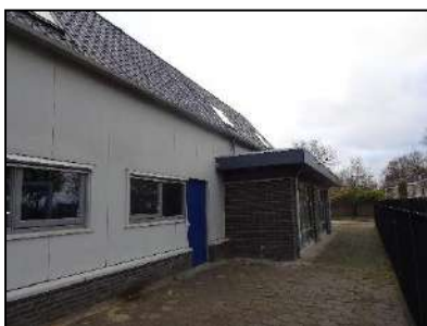
Figuur 6. Bedrijfsgebouw, kijkrichting noord.
