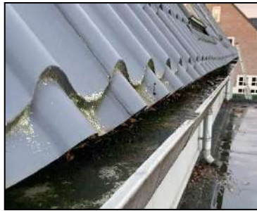
Figuur 11. Dakgoot van het bedrijfsgebouw.
