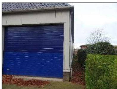
Figuur 7. Bedrijfsgebouw, kijkrichting zuidwest.
