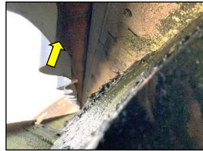
Figuur 12. Ruimte voor huismus onder de golf van de dakplaten.
