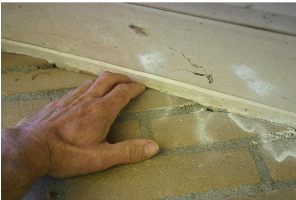
Figuur 5. De gevel van het woonhuis sluit vrijwel overal nauw aan op de dakoversteek.
