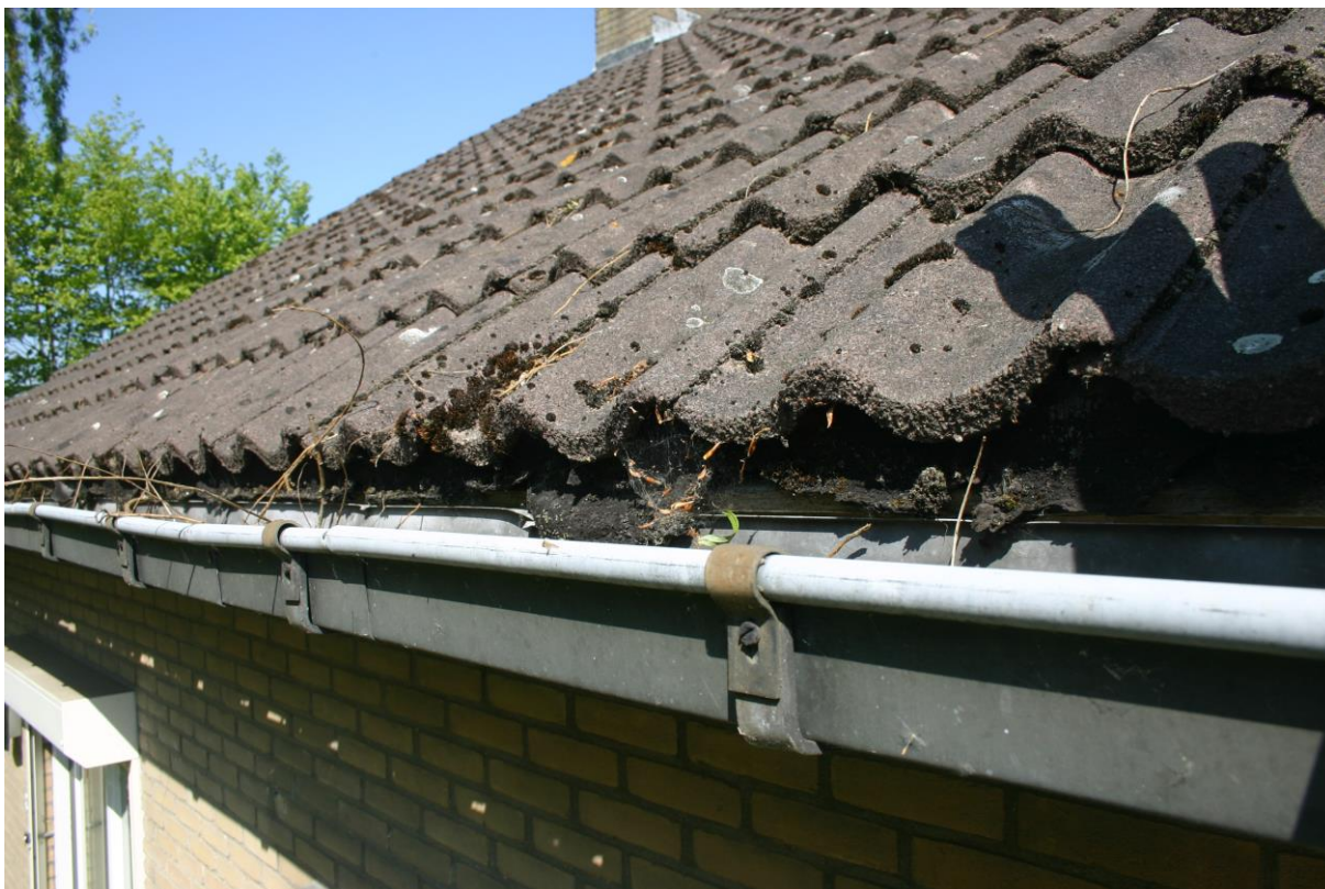
Figuur 4. De ruimte onder de dakpannen is te nauw voor vogels.
