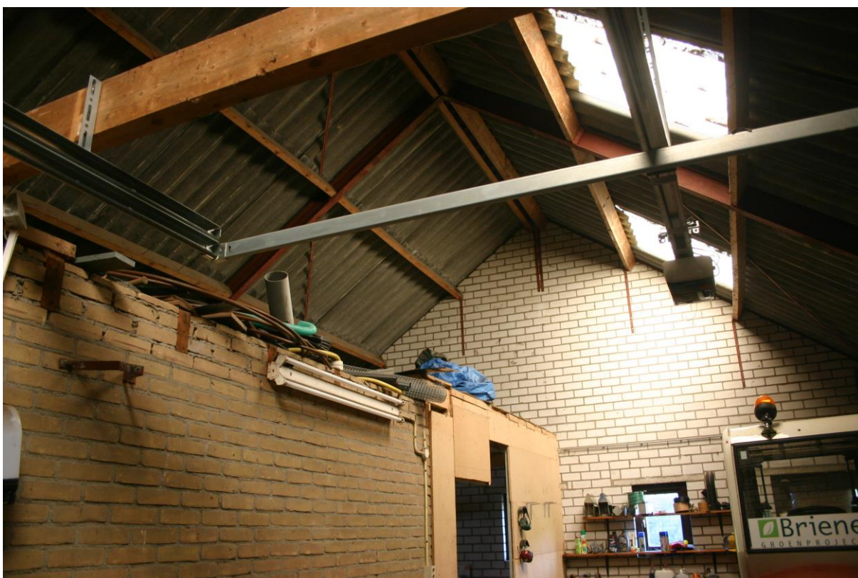
Figuur 9. Het garagedak is enkelwandig.
