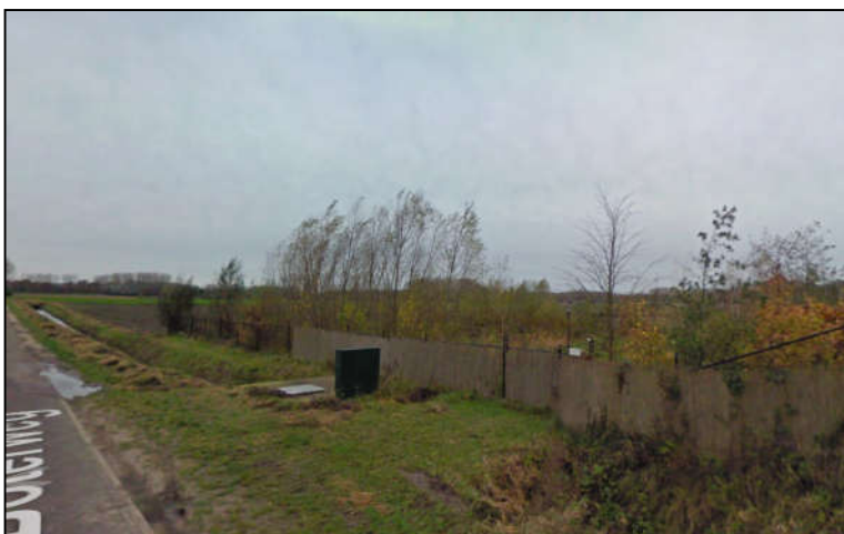
Figuur 23: Foto plangebied met op de voorgrond de duiker en het gemaal (Bron: Google Streetview)
