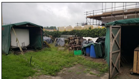
Figuur 5. Opslag zuidelijk deel van de onderzoekslocatie.
