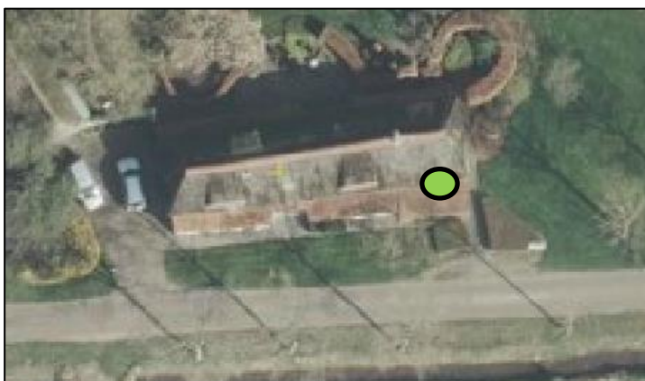
Raktstraat 8. Eén verblijfplaats bevindt zich aan de zuidoostzijde van het gebouw met één gewone dwergvleermuis.
