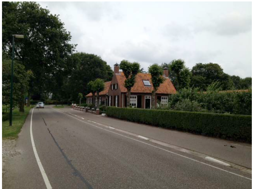
Planlocatie gezien vanaf Bedafseweg (kant kruising met Derptweg)
