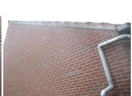
Enkele foto's van de te slopen bijgebouwen
