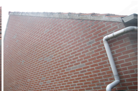
Enkele foto's van de te slopen bijgebouwen
