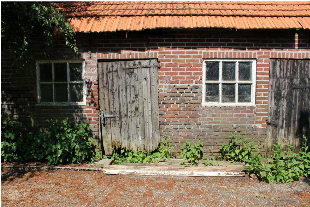
Duidelijk zichtbaar in de langsgevel aan de tuinzijde (langsgevel aan straatzijde is i.v.m. begroeiing niet zichtbaar) het verschil in metselwerk tussen oud en nieuw.
