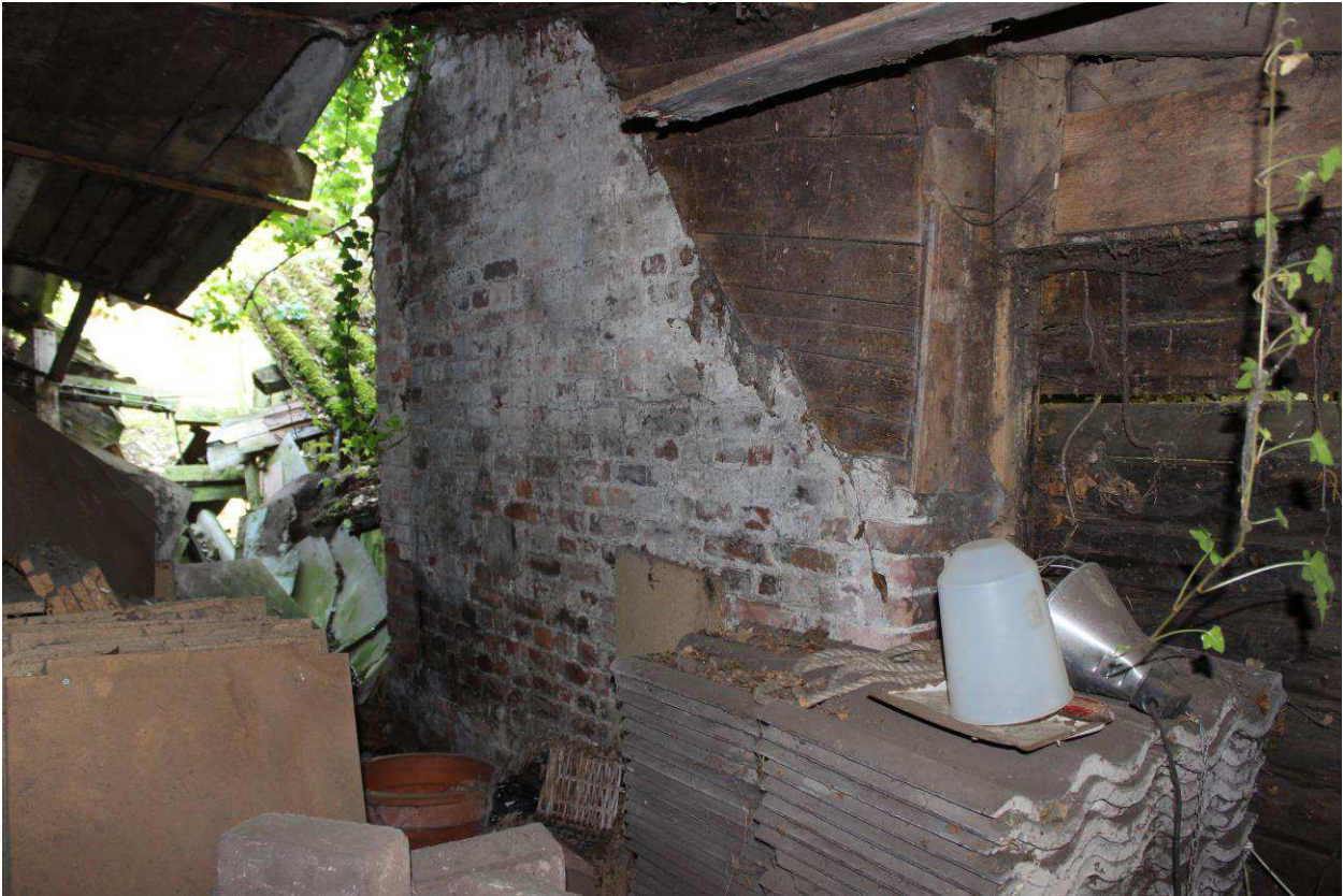
Kopgevel voorkamer met links op de hoek de contouren van de schoorsteen.
