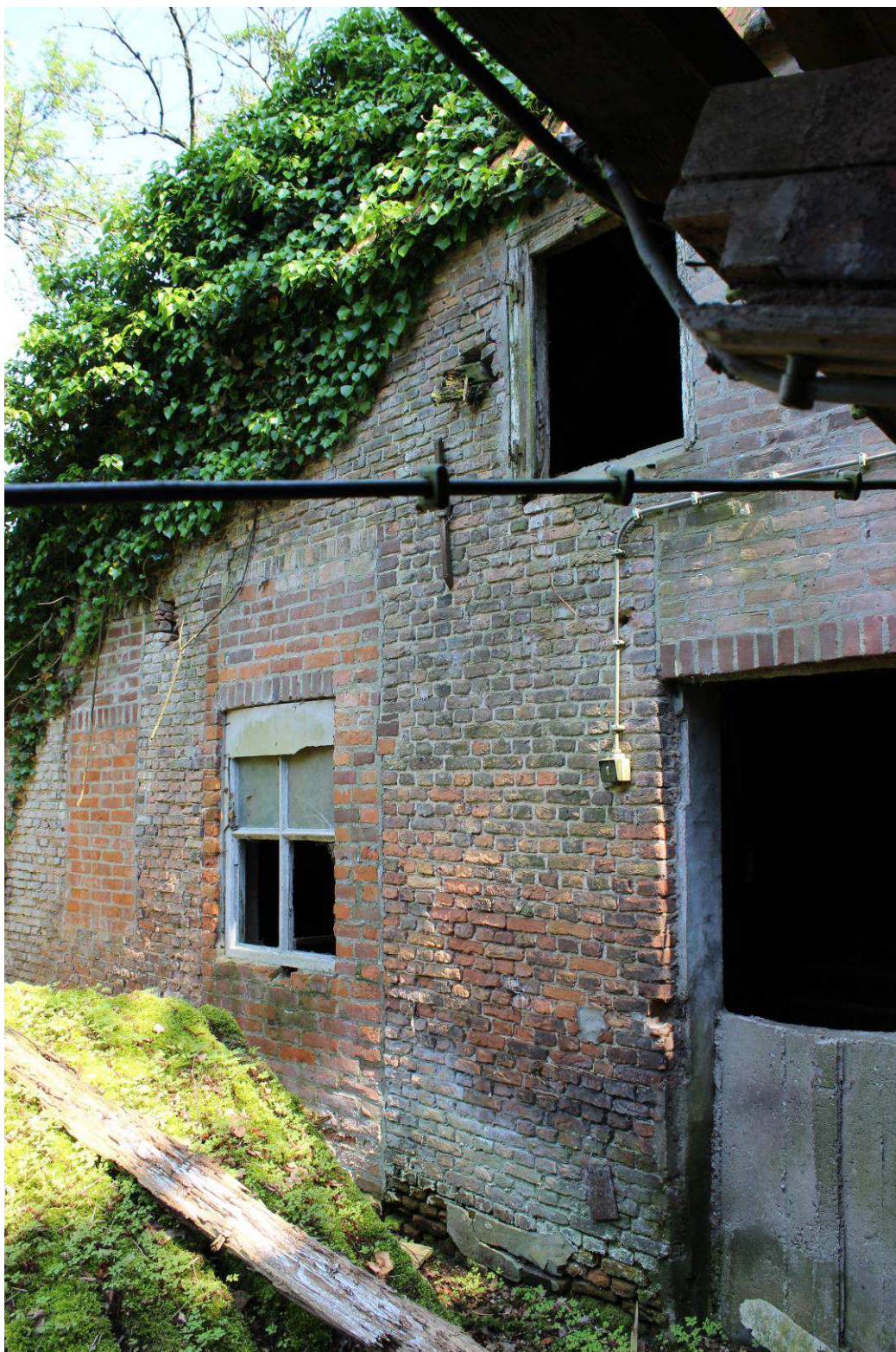
Oorspronkelijke voorgevel (kortgevelboerderij) waarin nog duidelijk zichtbaar de contouren van opkamerraam, kelderraam, en de voordeur met bovenlicht (zie ook afbeeldingen op volgende pagina)..
