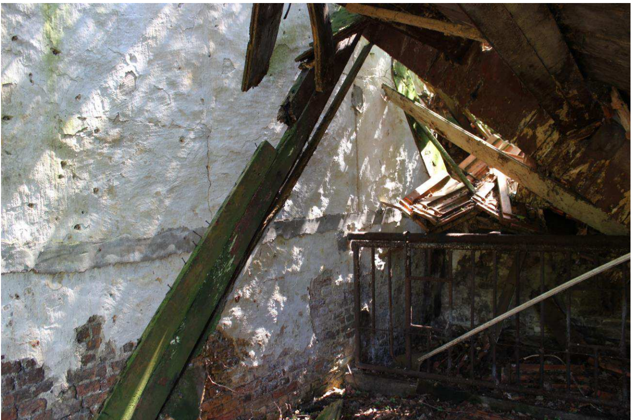
Stucwerk van de voorkamer tegen de oorspronkelijke voorgevel.
