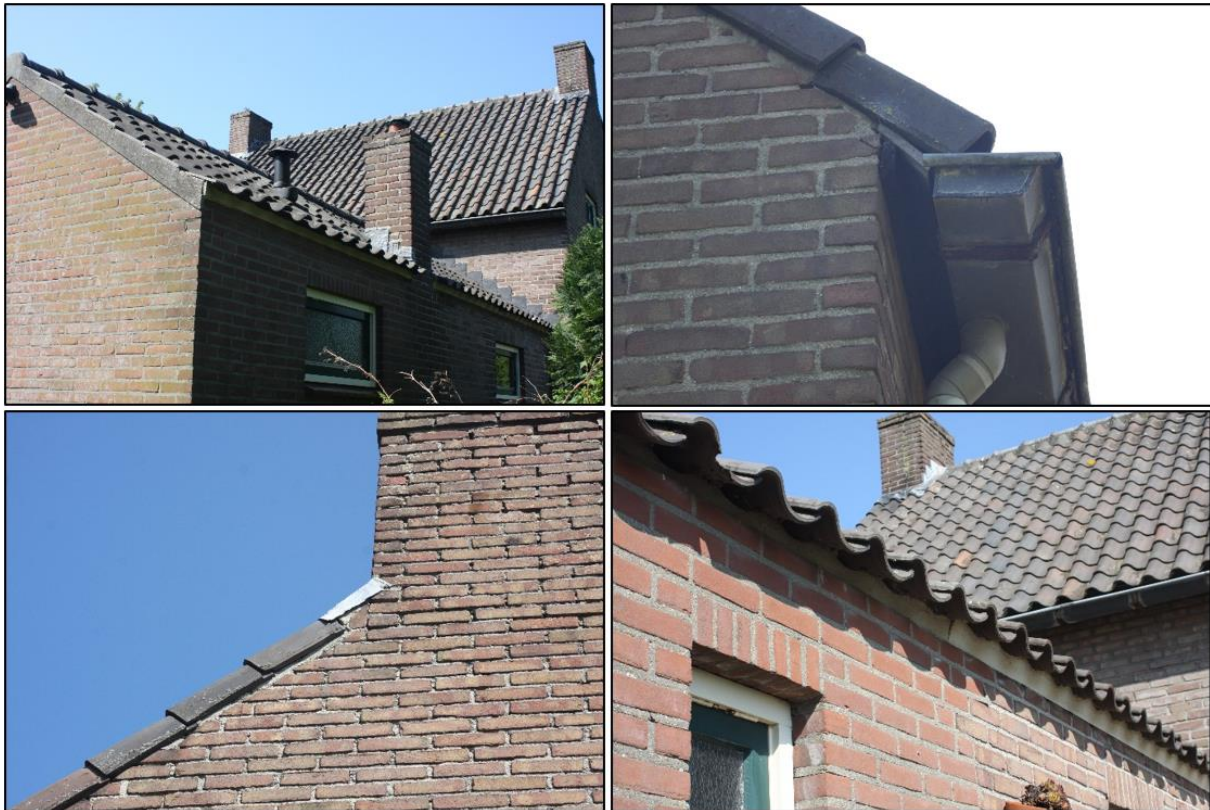
Figuur 2 Detailfoto's dak en gevels
