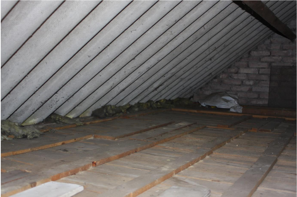
De zolder van het bijgebouw is deels afgedicht met glaswol
