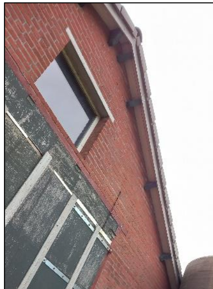
Foto B – dak te slopen schuur
