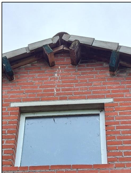
Foto A – dak te slopen schuur
