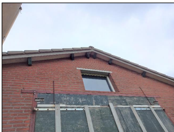
Foto A – dak schuur
