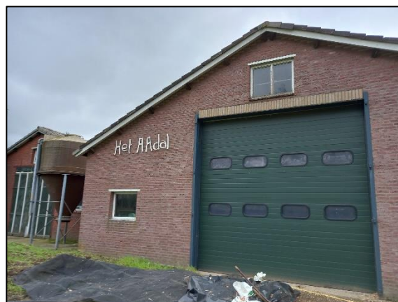
Foto B – dak schuur
