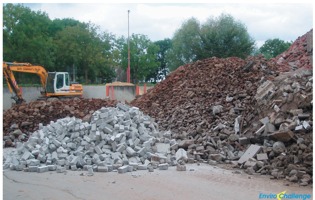
Illustratie 6 : Opslag van steenachtig bouw- en sloopafval (puin) op vloeistofkerende verharding
