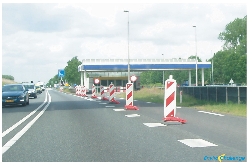
Illustratie 2 : LPG-tankstation "Total" aan Kanaaldijk-Noord op 25 juni 2015
