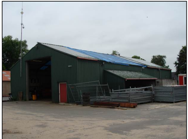
Foto 4. Werkplaats van damwandprofielen
