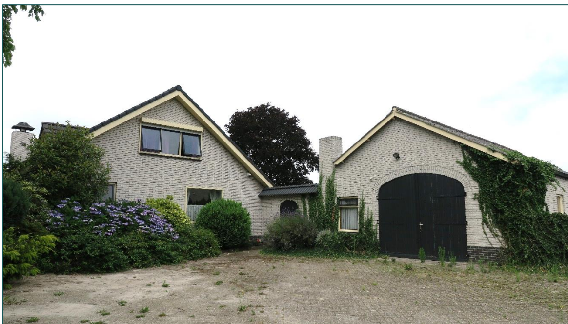
Figuur 2 De woning en grote schuur op de planlocatie blijven binnen de beoogde ruimtelijke ingreep behouden.
