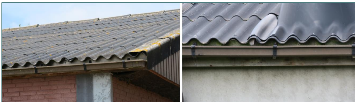
Figuur 3.1 De golfplaten daken van de varkensstallen zijn vrijwel overal aan de dakvoet van de bebouwing afgesloten.
