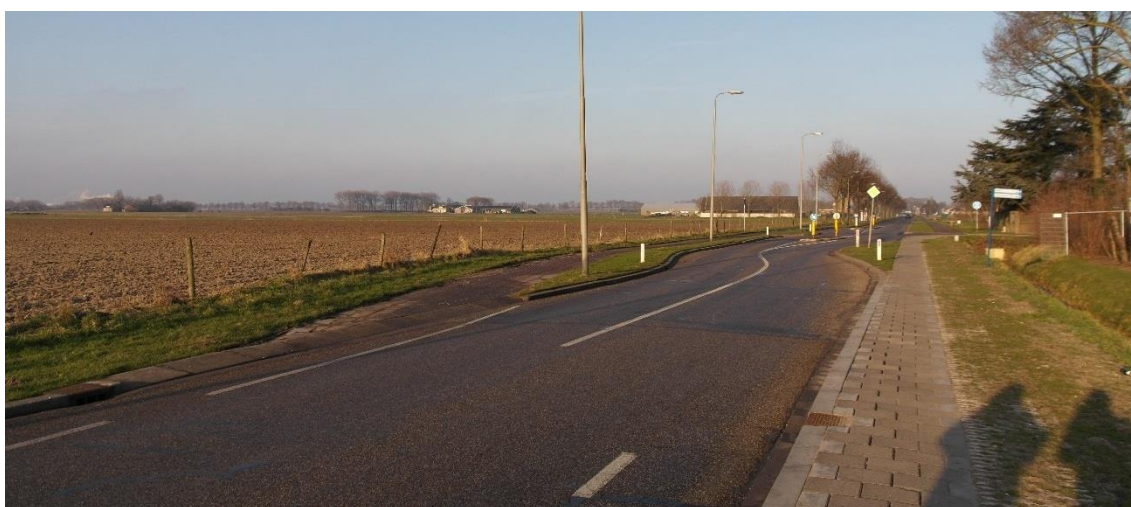
Figuur 23: situatie kruispunt met de Nieuwstraat gezien vanuit zuidelijke richting
