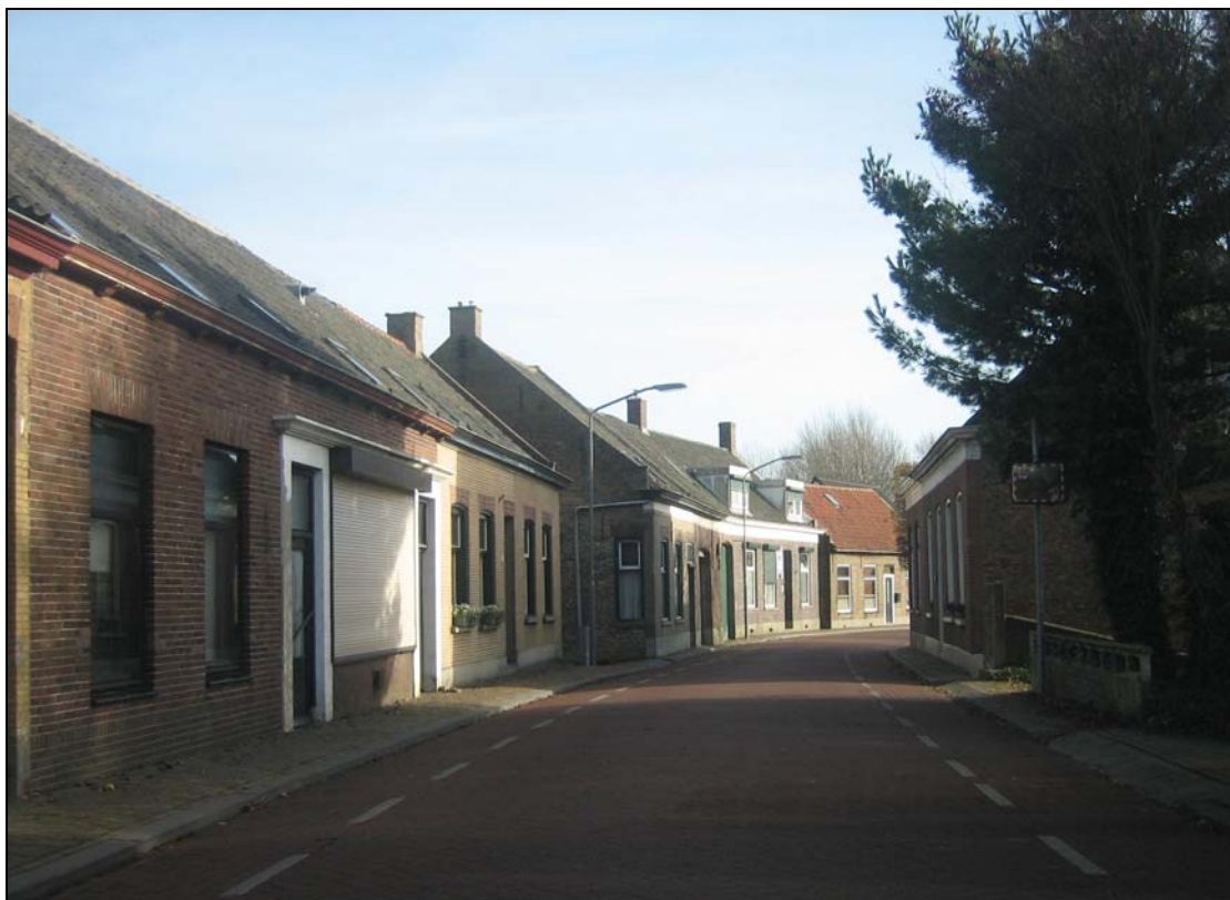
Figuur 3.5: Beperkte ruimte voor het doorgaand verkeer in de Spoorstraat te Hooge Zwaluwe
