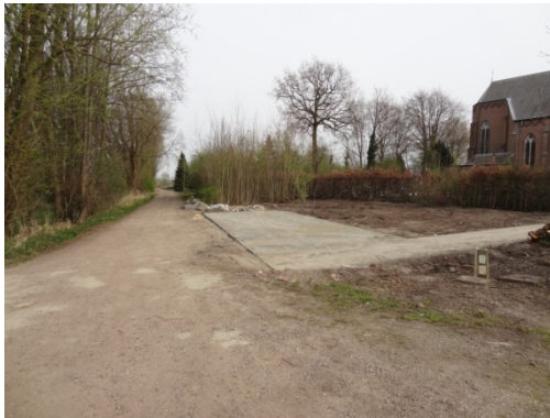
5 parkeerplaatsen ten noorden van de begraafplaats die recent zijn aangelegd
