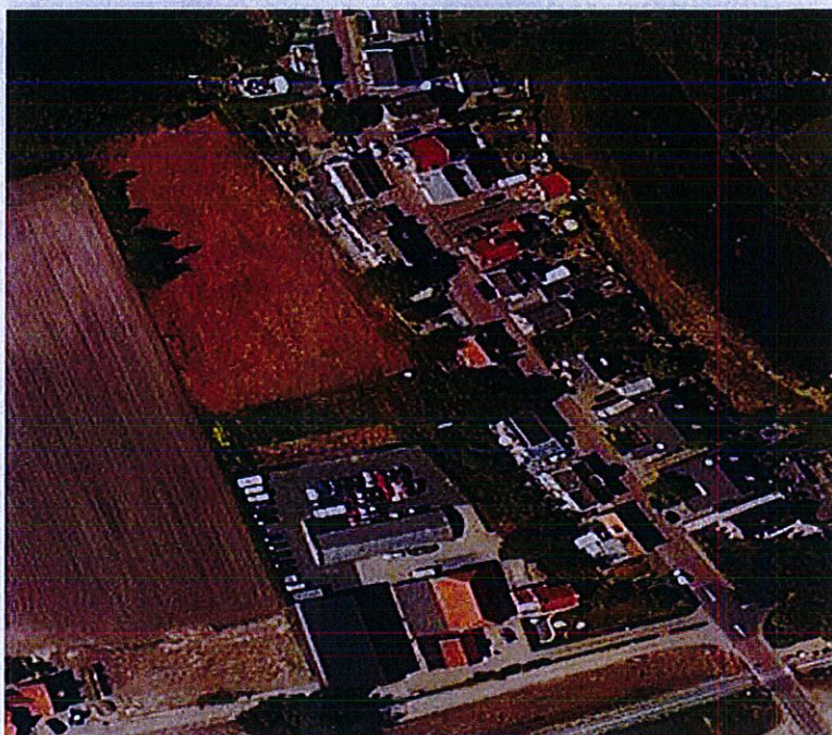
Figuur 3.1 Huidige situatie Spoorstraat 32 Hooge Zwaluwe (bron: Bing Maps)
