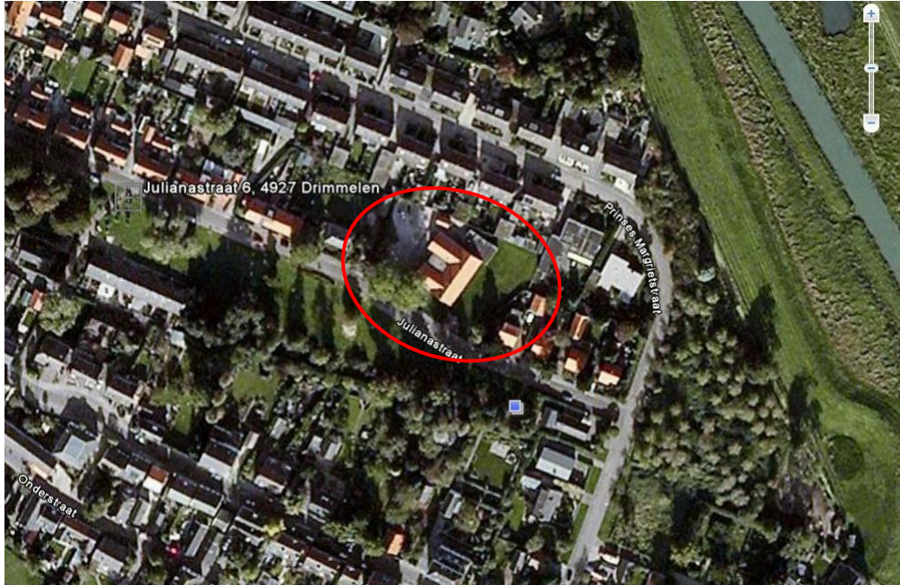
Het plangebied Julianastraat te Hooge Zwaluwe (gem. Drimmelen) op een luchtfoto (bron: Google Earth)
