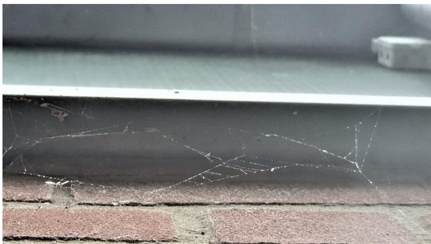
Figuur 4.4.2. De damwandplaten sluiten nauw aan op de spouwmuren.
