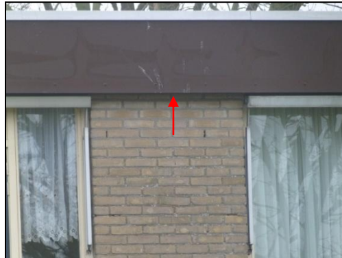
Figuur 10. Ruimte achter betimmering.
