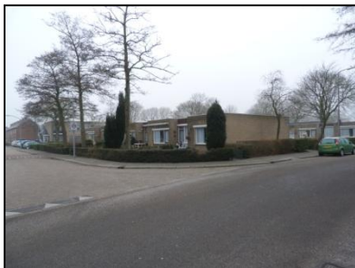
Figuur 3. Zuidzijde onderzoekslocatie.
