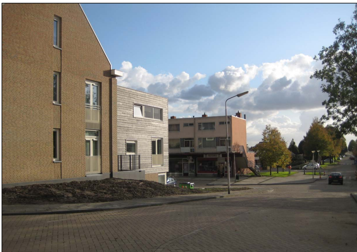
De ligging van het plangebied, gezien vanaf het dijklint (Kerkstraat). Zichtbaar is het hoogteverschil tussen het dijklint en de zogenoemde onderstraat.
