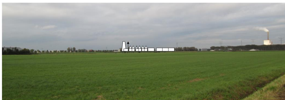
(de zwarte pijl geeft de hoogte van de zendmast weer.)
