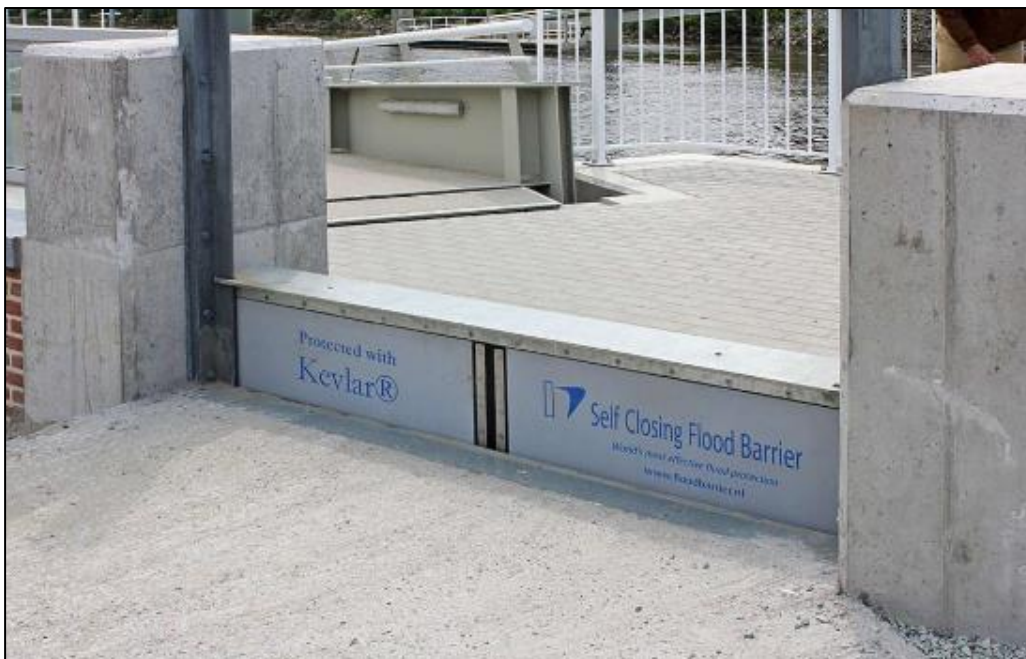
Figuur 14: voorbeeld zelf sluitende keerwand. Bron: floodcontrolinternational.com, 2024.
