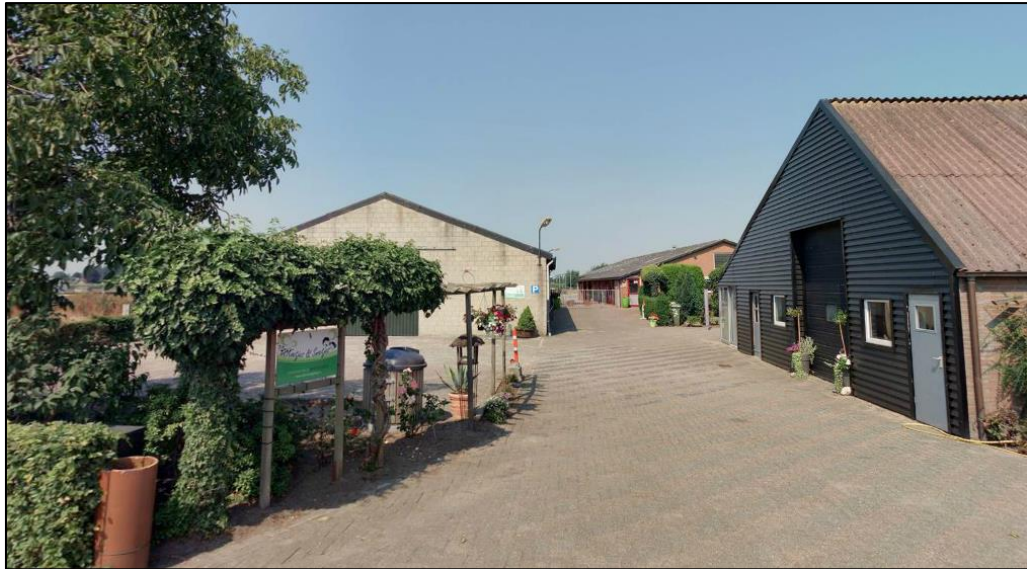
Bedrijfsgebouwen kinderdagverblijf links en midden. Bron: Cyclomedia, 2019.
