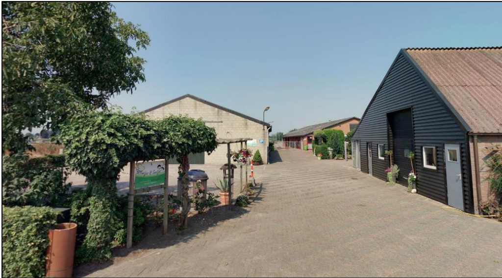
Bedrijfsgebouwen kinderdagverblijf links en midden. Bron: Cyclomedia, 2019.
