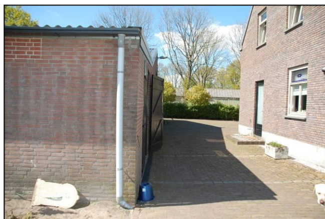
Links is het (bij)gebouw gesitueerd, rechts het (hoofd)gebouw. Tussen beide gebouwen is een afstand van circa 4 meter aanwezig.
