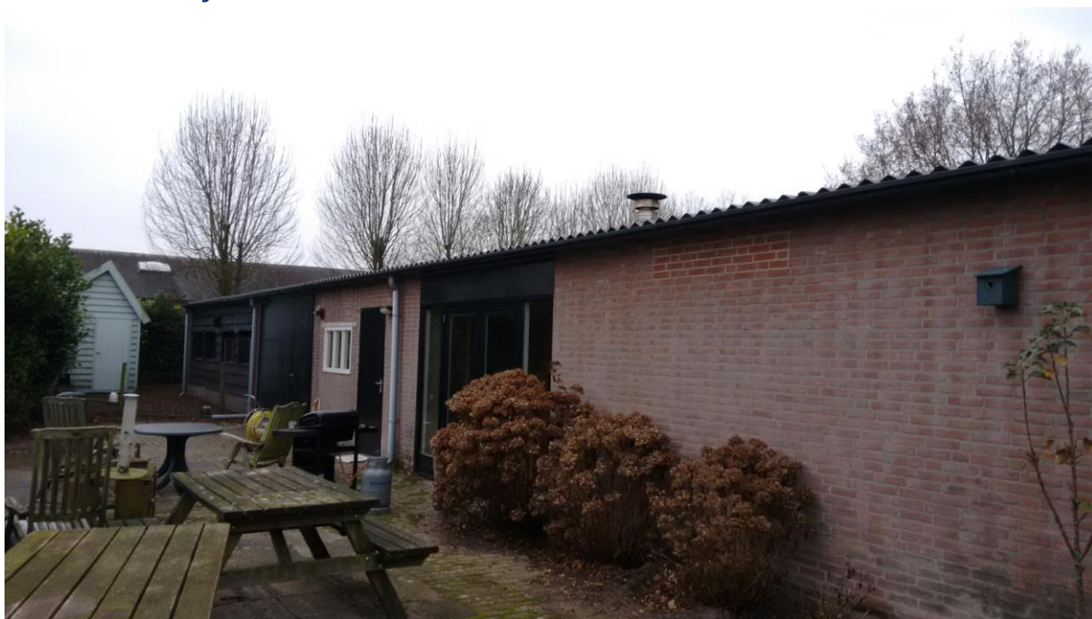
Loods aan zuidzijde vanuit het zuidoosten
