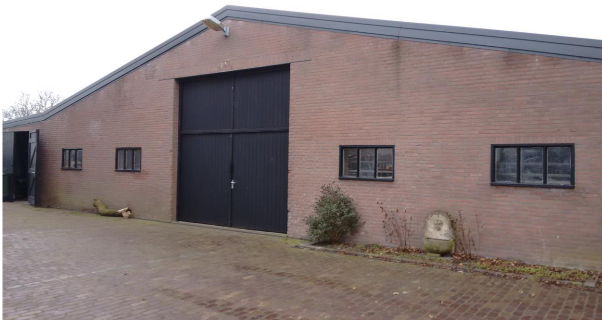
Vanuit het noordoosten op de oostelijke gevel van de loods
