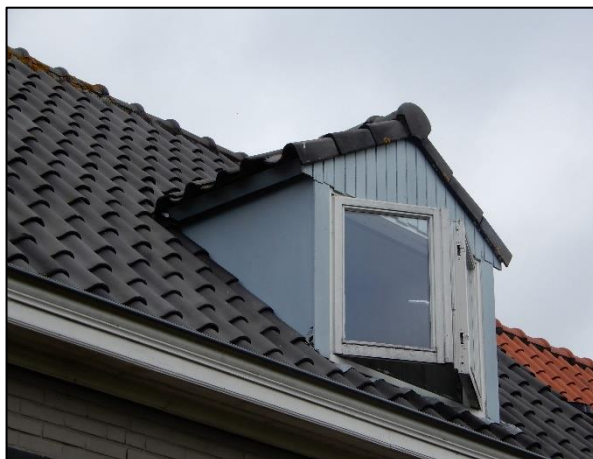
Foto C dakkapel van woning
