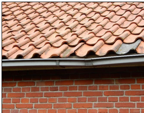
Foto D dak van schuur
