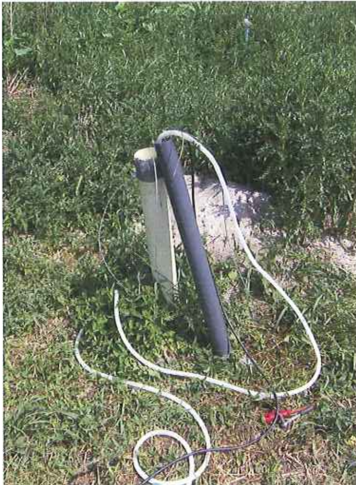
installatie onderwaterpomp in onttrekkingsfilter
