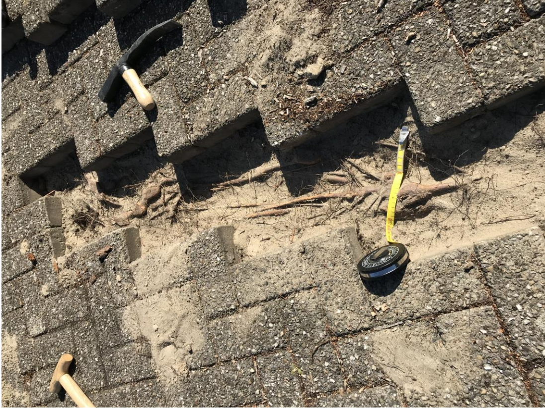
Figuur 6 Aangetroffen beworteling direct onder verharding bij de Hollandse linde: lokaal dichte 'netten' met opnamewortels en wortelverdikkingen (reactiegroei).
