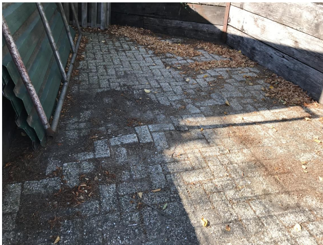
Figuur 5 Impressie aangetroffen wortelopdruk onder klinkerverharding in projectgebied, in de groeiplaats van de Hollandse linde.
